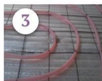
3 Уложите арматурную сетку и закрепите трубу
